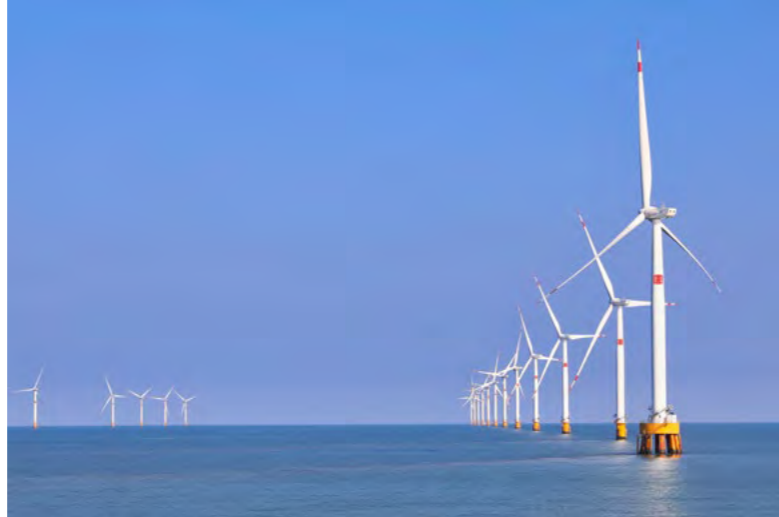
▲ 中国大唐福建平潭长江澳海上风电项目每年向平潭岛输送绿色电力超 8 亿千瓦时，有力推动能源转型
