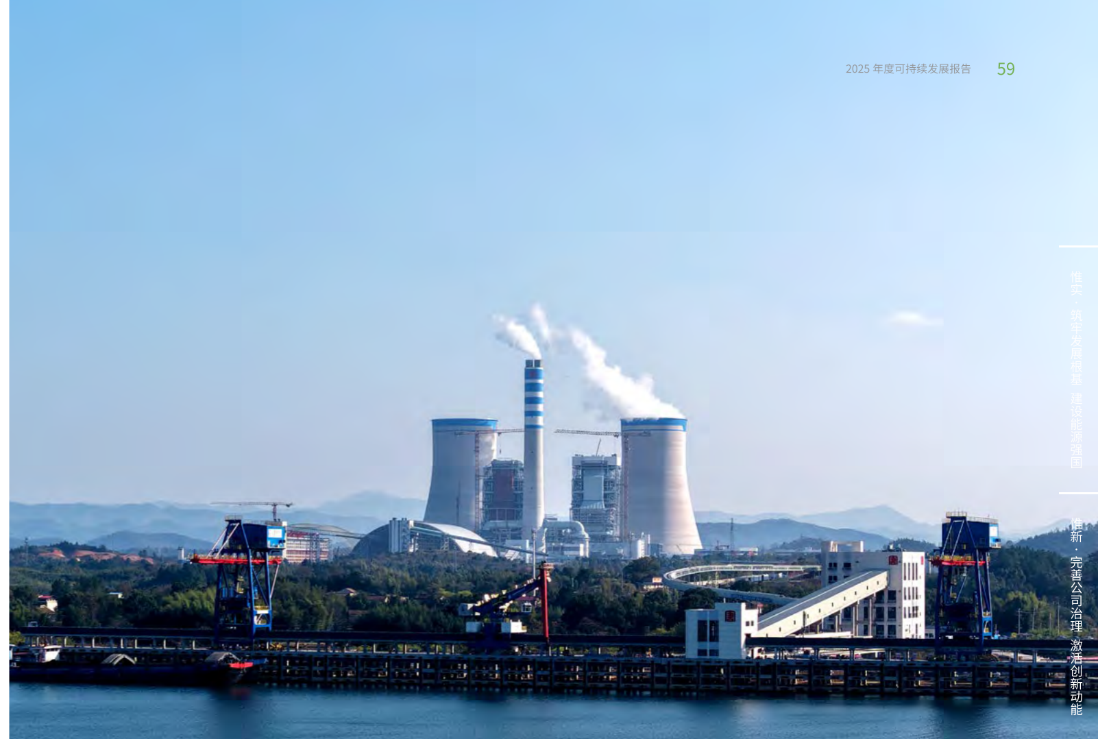
▲ 大唐华银株洲百万煤电项目
