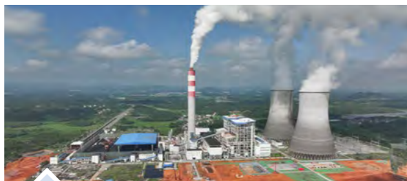
江西抚州电厂——20MWth 化学链燃烧发电成套装备
