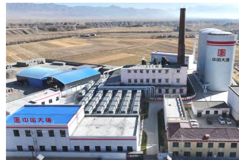
▲ 青海能源公司“空气源热泵 + 电锅炉 + 水蓄热”创新技术路线，比传统煤锅炉节能 40% 左右
