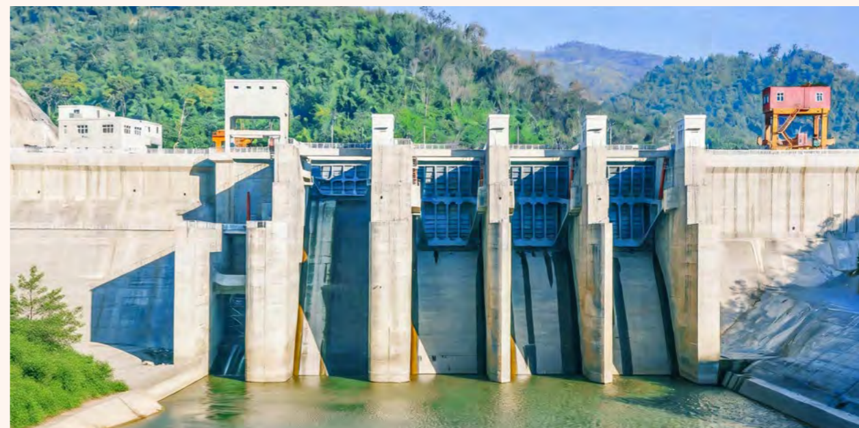
▲ 中国大唐首个境外投资项目——缅甸太平江一级水电站荣获“能源国际合作最佳实践案例”
