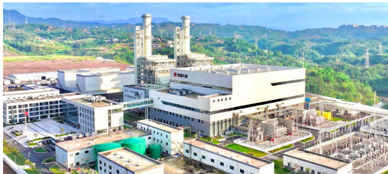
▲ 2025年11月28日，中国大唐在西南地区首个燃机项目——重庆江津燃机项目2号机组顺利通过168小时试运行，标志着该项目实现全容量投产发电
