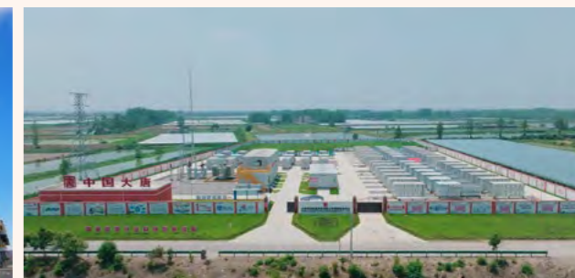
我国首个百兆瓦时钠离子储能项目——大唐湖北钠离子新型储能电站科技创新示范项目一期工程建成投运
