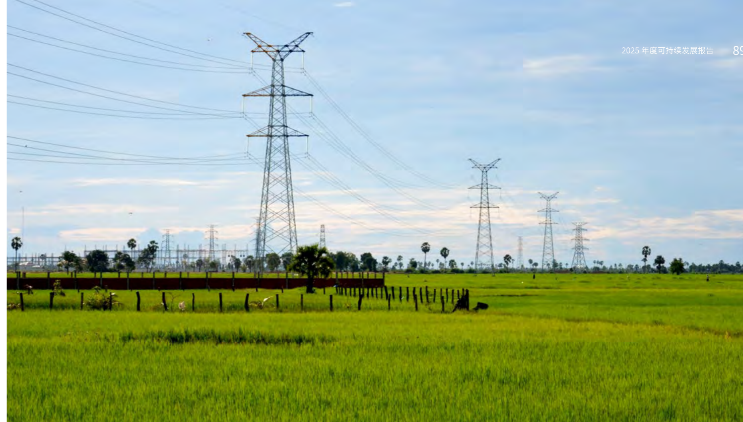
柬埔寨首个国家骨干电网——中国大唐柬埔寨电网工程
